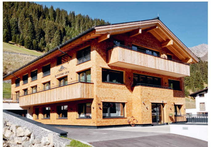
Der Neubau in Lech läutet eine neue Ära ein.
